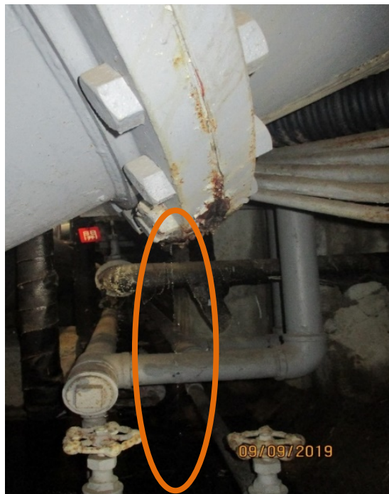
二次冷却系配管 止水前
