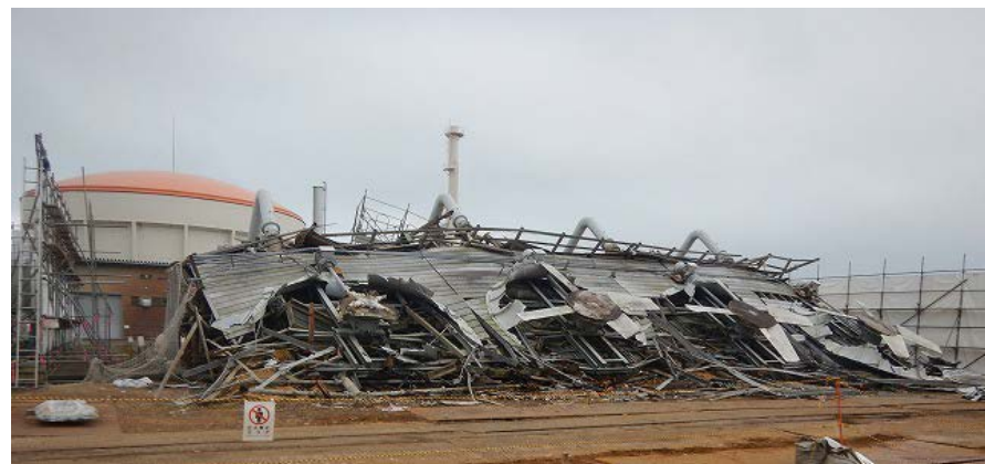
撤去中状況(西側)(令和元年12月11日撮影)
